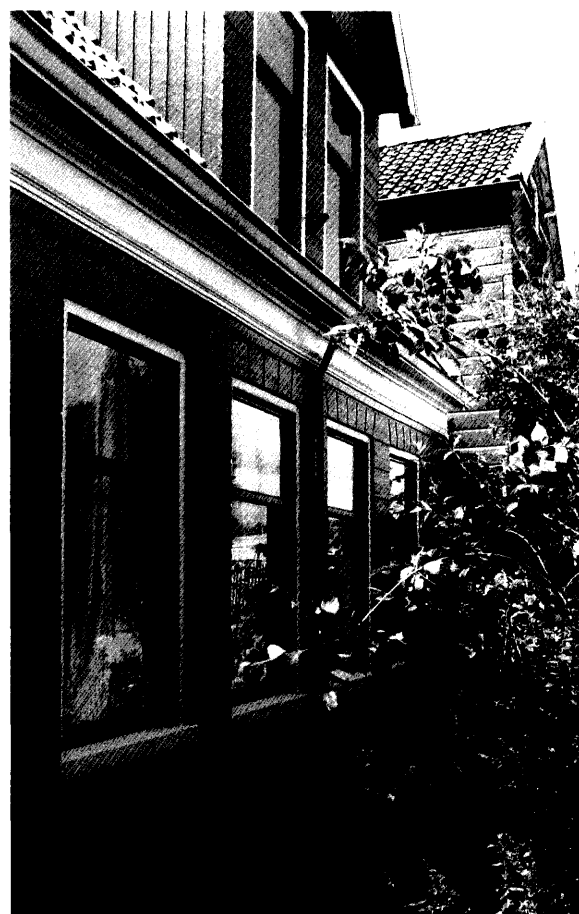
Westzijde 155; de houten beschieting van de voorgevel met boven de kozijnen verticale zaagsneden als natuursteenimitatie.
